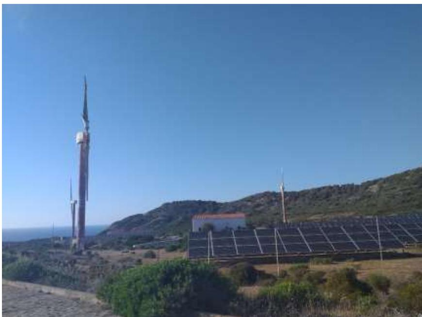
Figura 12 Foto dell'impianto di Nasca dalla quale sono visibili le tre pale eoliche non più funzionanti (ma non dismesse) e l'impianto fotovoltaico regolarmente in funzione.
